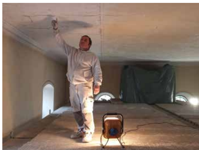
Sascha Krautschneider prüft den Zustand der Kirchendecke.
