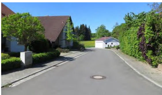
Bild 5: vorhandener Anschluss im best. Wohngebiet
