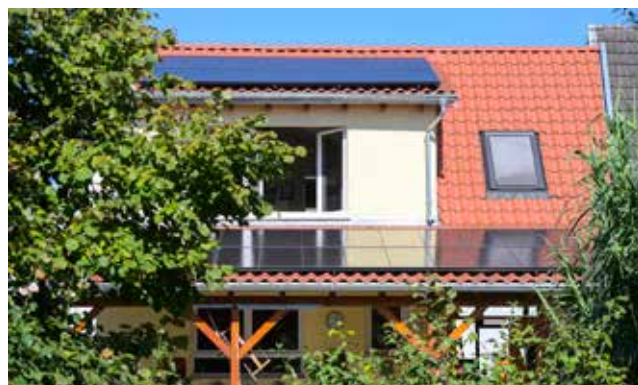
Ein 120 Jahre altes umfassend saniertes Haus in Plankstadt – erneutes Dach und Außenwände gedämmt, neue dreifachverglaste Fenster und eine Photovoltaik-Anlage mit insgesamt 9,9 kWp starken Leistung. Gülay Keskin
