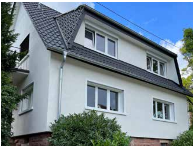
Das Einfamilienhaus aus den 50er Jahren in Heidelberg wurde energetisch umfassend modernisiert – bei der Dachsanierung wurden insg. 28 cm bei der Außenfassade 12 cm Dämmmaterial verbaut.
