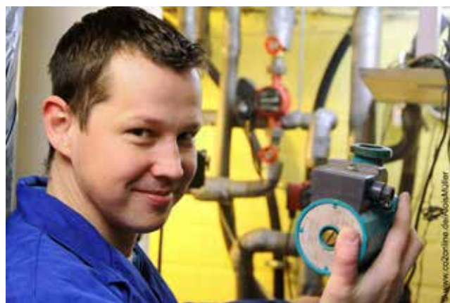
Hocheffizienzpumpen sowie der hydraulische Abgleich werden aktuell über das Zuschuss-Programm „Heizungsoptimierung“ der BAFA gefördert. Fragen Sie im Vorfeld Ihren KLiBA-Berater. Foto: CO2-Online
