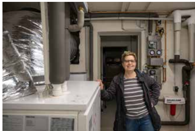
Das Einfamilienhaus in Heidelberg wird vollständig durch eine komplett im Keller untergebrachte Luft-Wasser-Wärmepumpe beheizt. Wärmepumpe und der hydraulische Abgleich wurden durch die BAFA gefördert. Foto: Gülay Keskin
