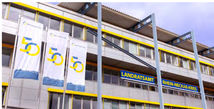
(Landratsamt Rhein-Neckar-Kreis): Vor dem Landratsamt in der Kurfürsten-Anlage 38 - 40 in Heidelberg wehen drei Fahnen zum Jubiläum „50 Jahre Rhein-Neckar-Kreis“.
