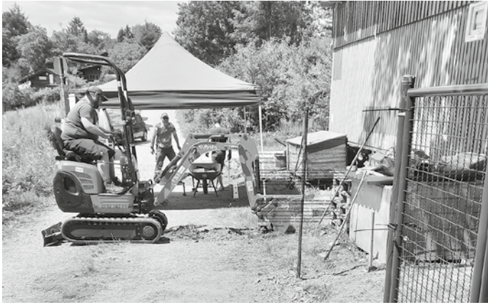
Bild 1-Kleinbagger im Einsatz (Bild: Robin Bandini)
